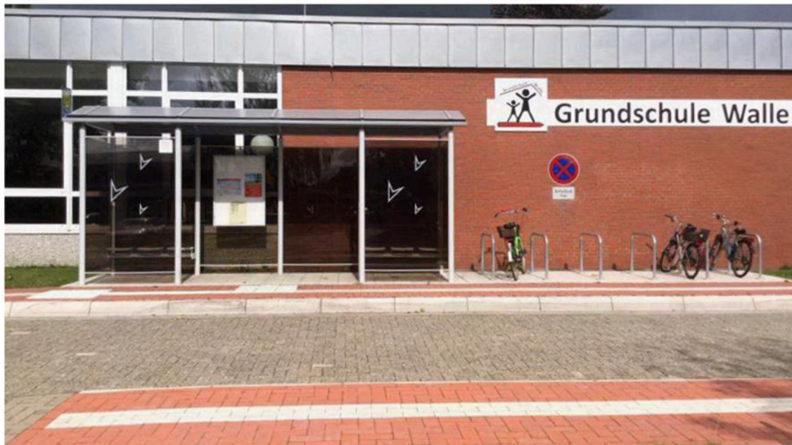
Abbildung: A - 15, Ausgebaute Haltestelle GS Walle
